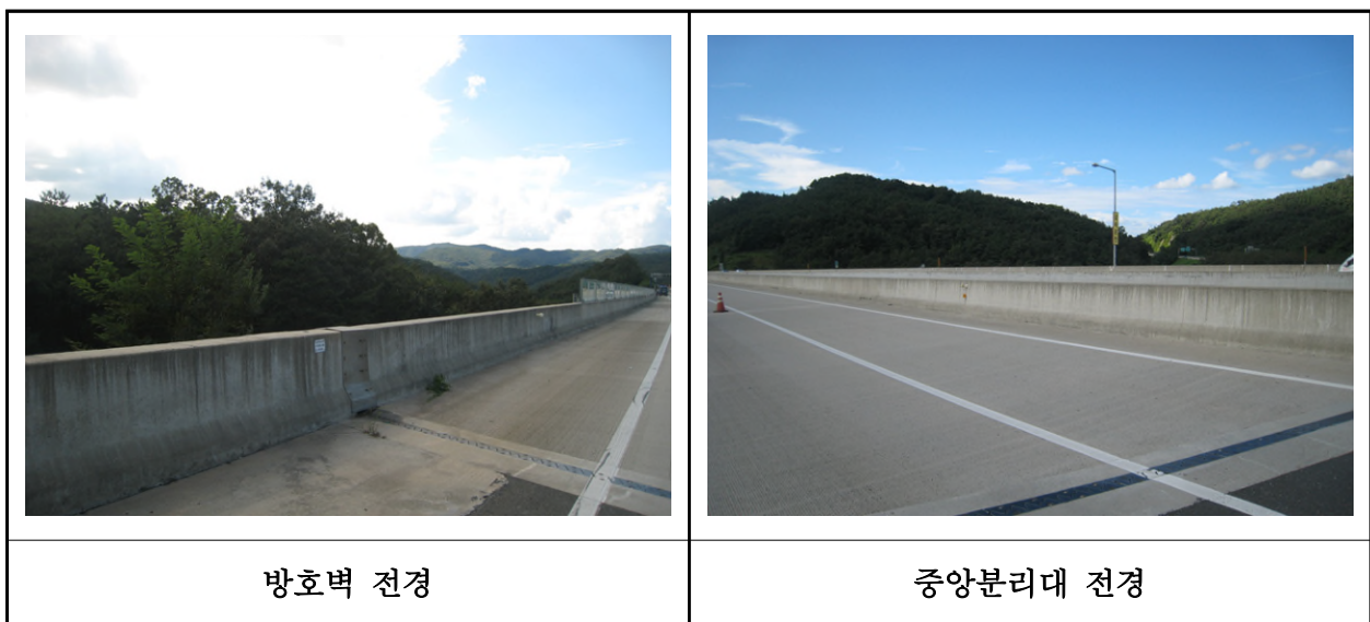
【사진 11.3.48】 방호벽 및 중앙분리대 전경
