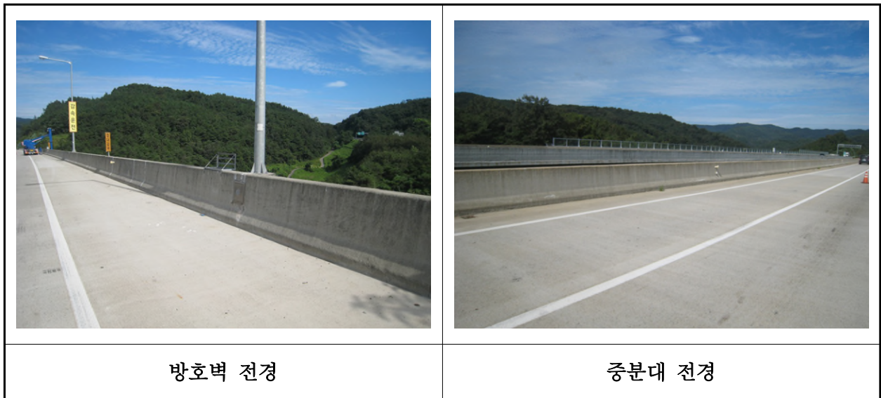
【사진 11.3.23】 방호벽 및 중앙분리대 전경
