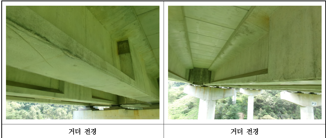
【사진 11.3.4】 거더 전경
