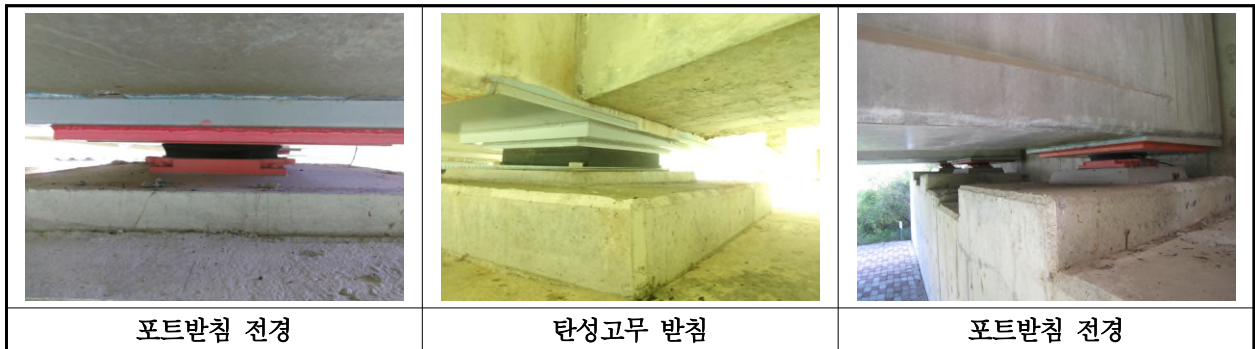
【사진 11.3.35】 교량반침 전경
