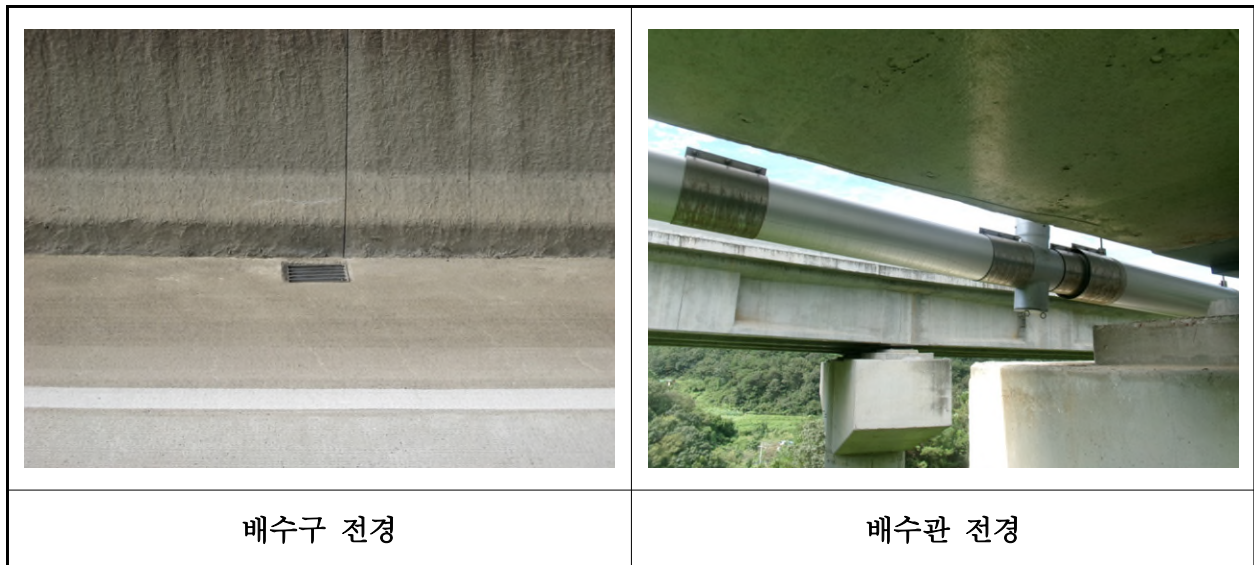
【사진 11.3.21】 배수시설 전경
