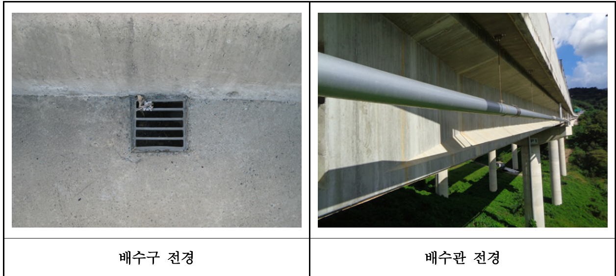
【사진 11.3.46】 배수시설 전경
