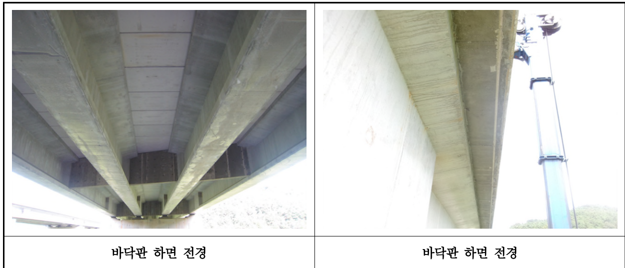
【사진 11.3.2】 바닥판하면 전경
