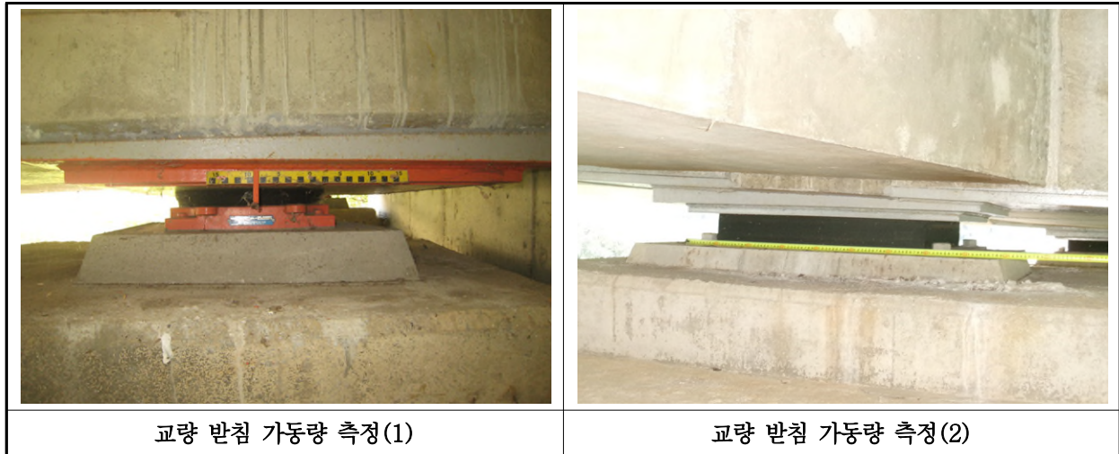
【사진 11.3.38】 교량받침 이동량 측정
