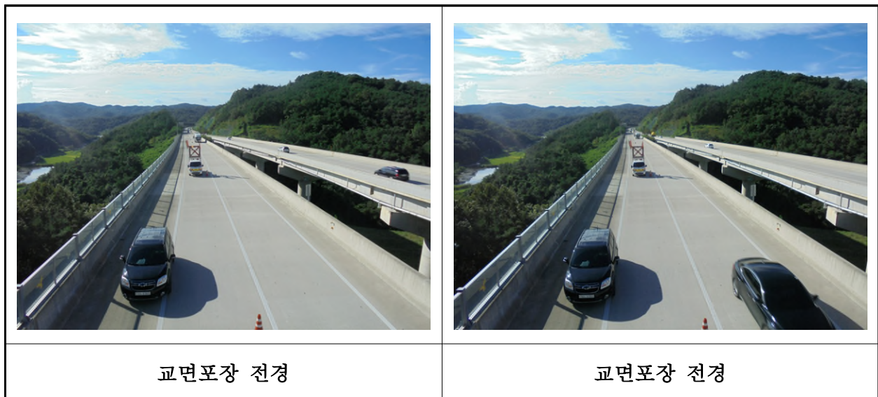
【사진 11.3.44】 교면포장 전경
