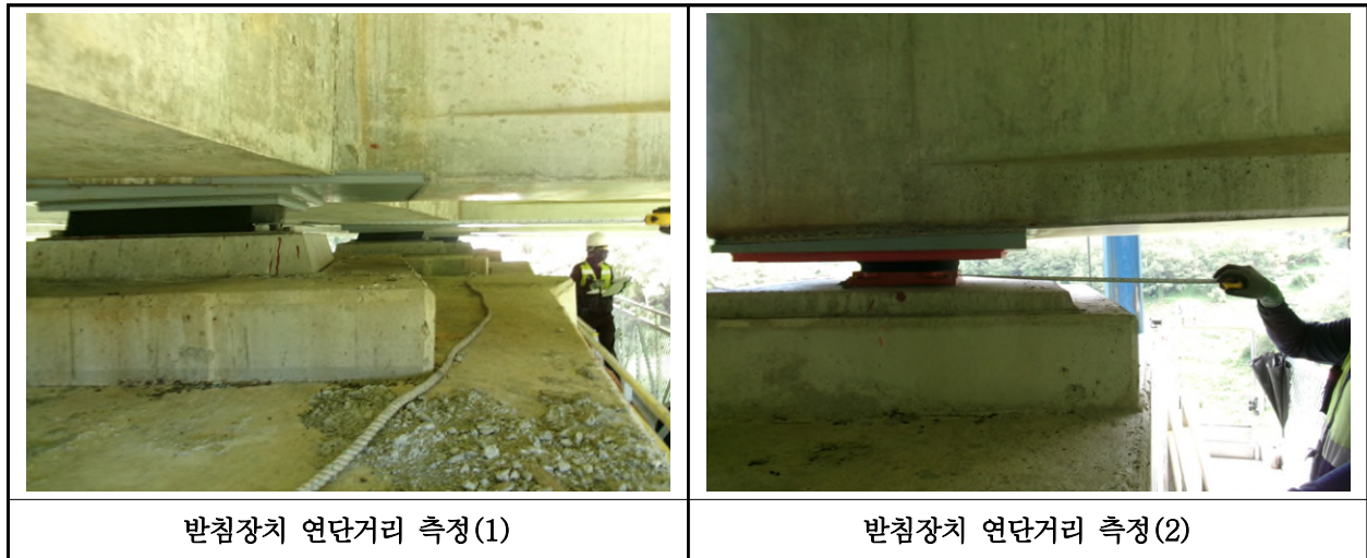
【사진 11.3.14】 교량받침장치 연단거리측정
