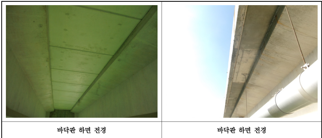
【사진 11.3.27】 바닥판하면 전경
