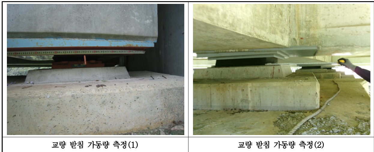
【사진 11.3.15】 교량받침 이동량 측정
